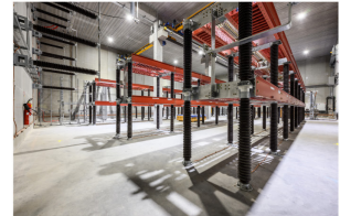
3-phase HV diode rectifier
